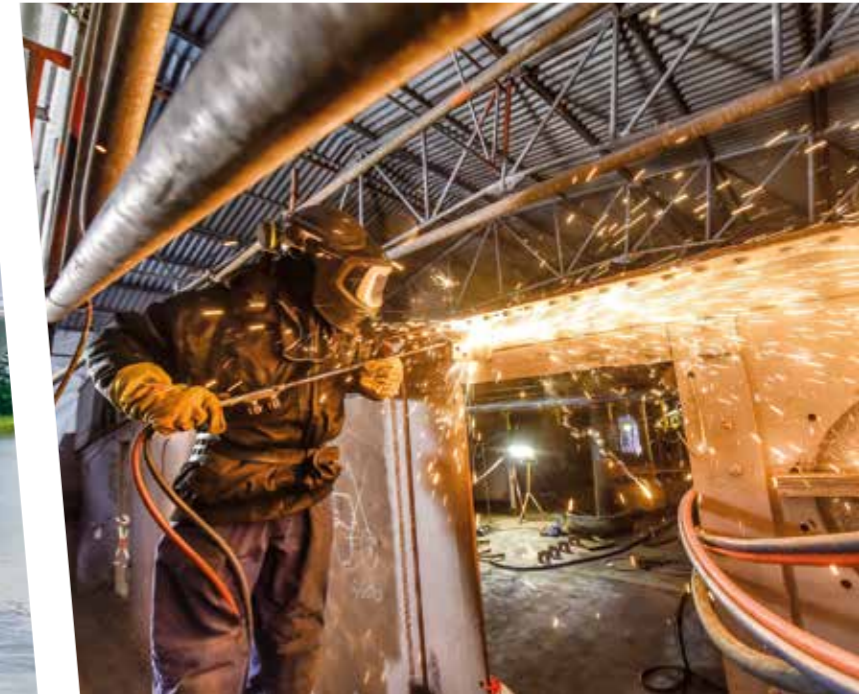
UNTER DECK: Mit einem Brenner werden überflüssige Teile entfernt.
