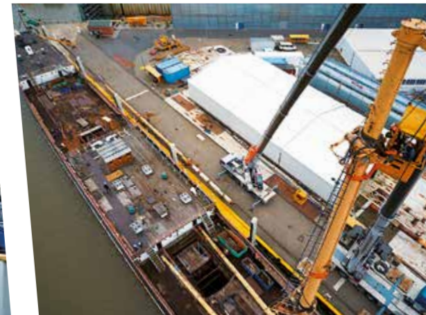
IN WEWELSFLETH: Auf der Peters Werft wurden per Autokran die Masten gezogen.
