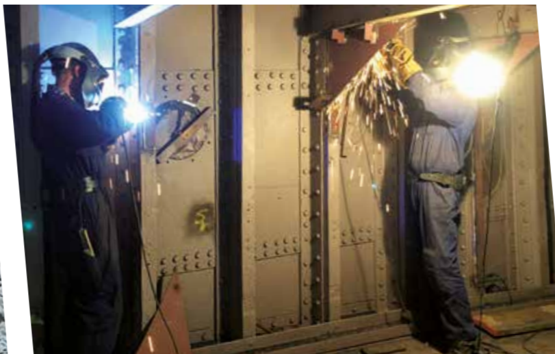
TEAMWORK: Bis zu 30 Fachkräfte arbeiten gleichzeitig auf dem historischen Schiff.
