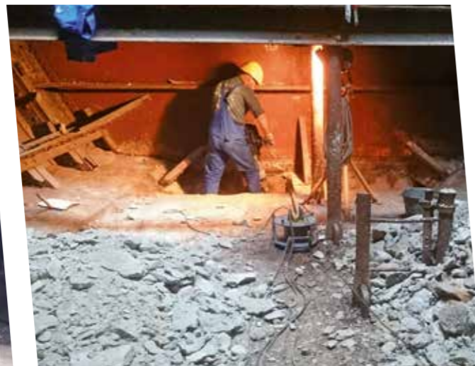
MÜHSAM: 1932 wurde tonnenweise Beton als Ballast ins Schiff eingebracht, was die jetzigen Arbeiten zusätzlich erschwerte.
