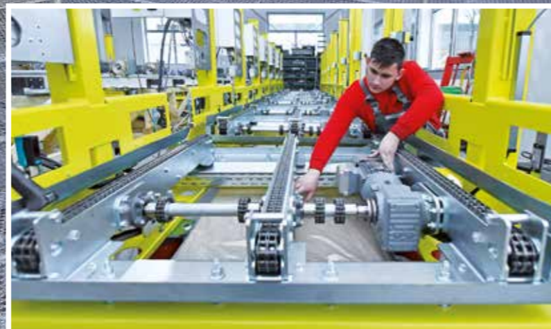
NACHWUCHS: Dennis Enns, einer der Auszubildenden von Louis Schierholz, an einer Elektrohängebahn, die von einem großen Industriekunden bestellt wurde.
