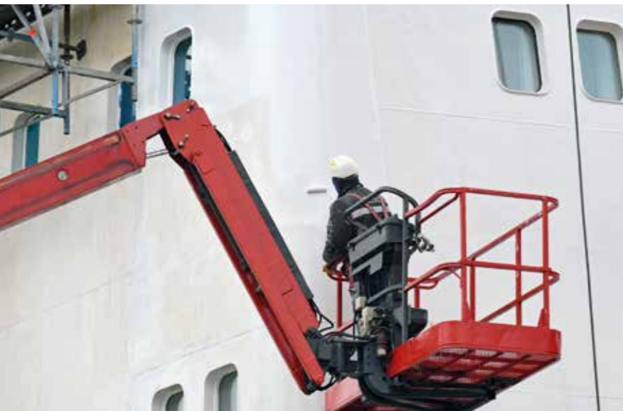
NEUER LACK: Im Unter- und Überwasserbereich des Rumpfs wurden Farb- und Konservierungsarbeiten durchgeführt.
