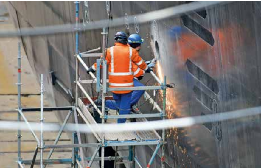
ÜBERHOLUNG: Der Aufenthalt auf der Werft wurde für zahlreiche Ausbesserungsarbeiten genutzt.
