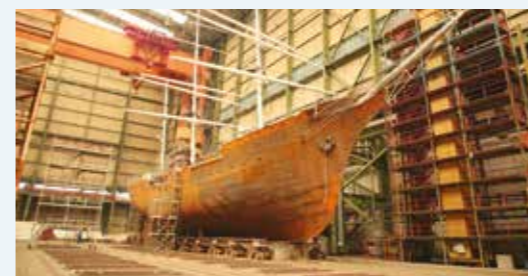
IN DER HALLE: Der Stahlrumpf der „Gorch Fock I“, die auf der Volkswerft aufwendig instandgesetzt wurde.
